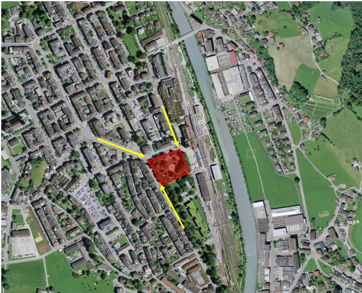
Figure 54: Aerial picture of Glarus (Bundesamt für Landestopographie (swisstopo), 2018)
